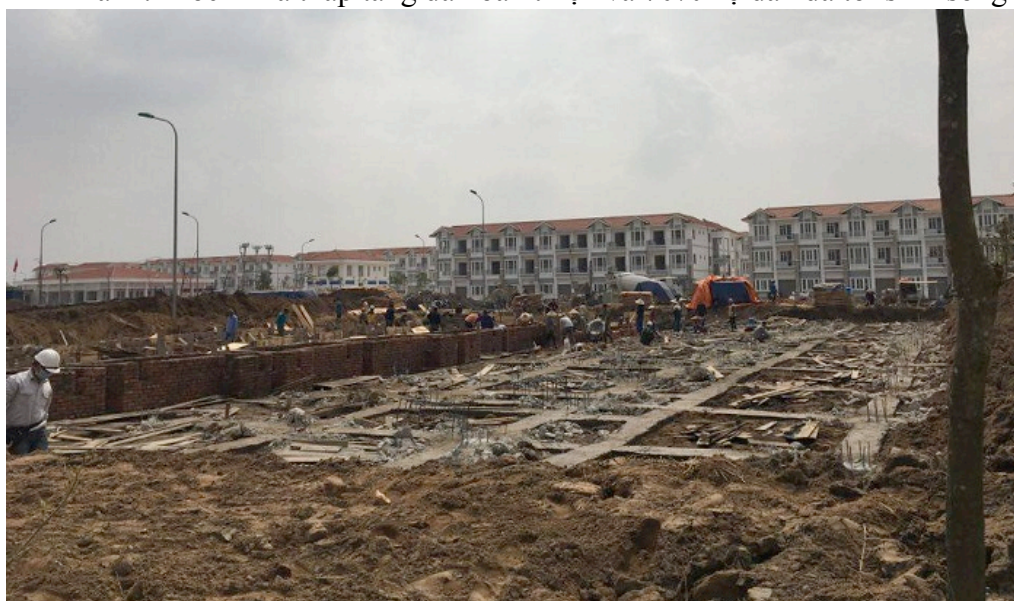
Hình ảnh: Block nhà đang thi công phần móng
